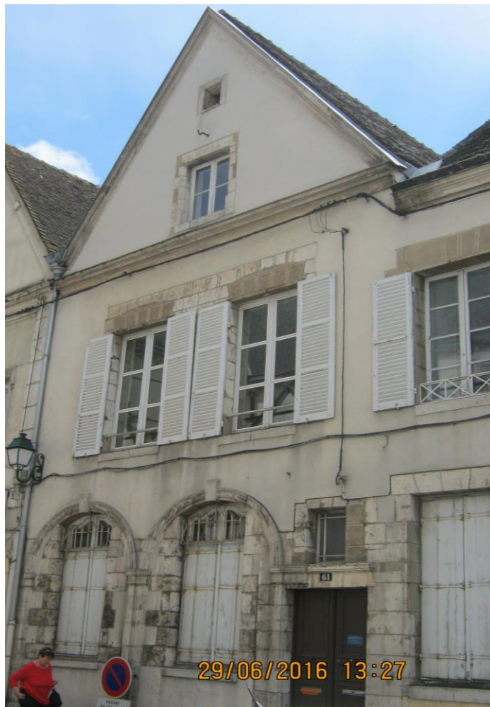
Façade côté rue
