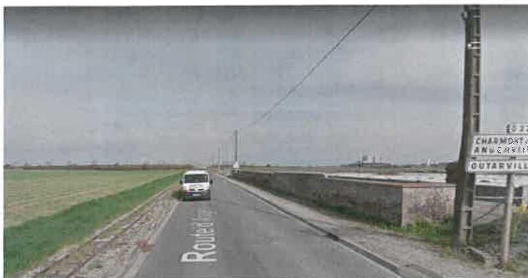
RD 22 hors agglomération en direction de la gare Bellebat – PR 1+080
