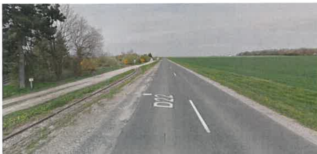
RD 22 hors agglomération – limite d'intervention départementale à la gare Bellebat – PR 4+030
