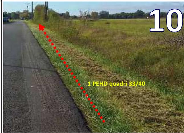
Pose d'un PEHD quadri 33/40 avec fil plynox en tranchée mécanisée (soc) en terrain naturel ou en accotement sur 60cm de profondeur
