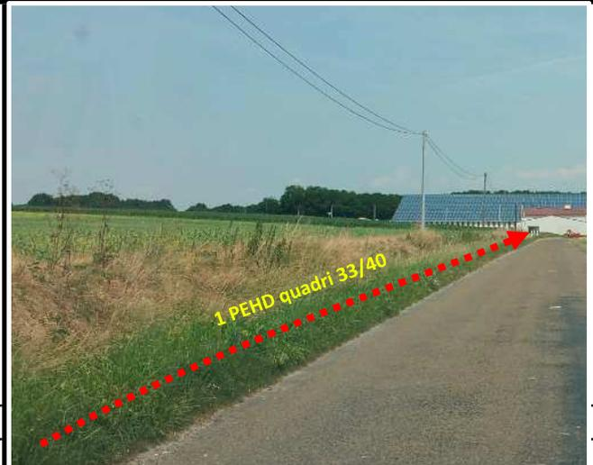
Pose de 1 PEHD quadri 33/40 avec fil plynox en tranchée mécanisée (soc) en terrain naturel ou en accotement sur 60cm de profondeur
