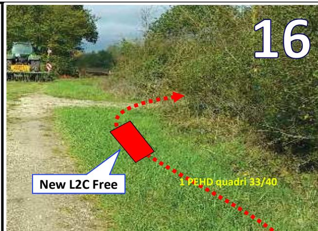
Pose d'un PEHD quadri 33/40 avec fil plynnox en tranchée mécanisée (soc) en terrain naturel ou en accotement sur 60cm de profondeur
