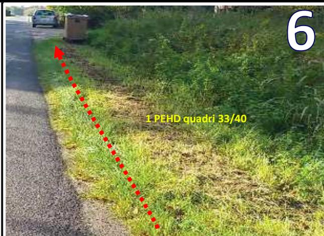
Pose d'un PEHD quadri 33/40 avec fil plynnox en tranchée traditionnelle en terrain naturel de largeur 40cm et profondeur 80cm
