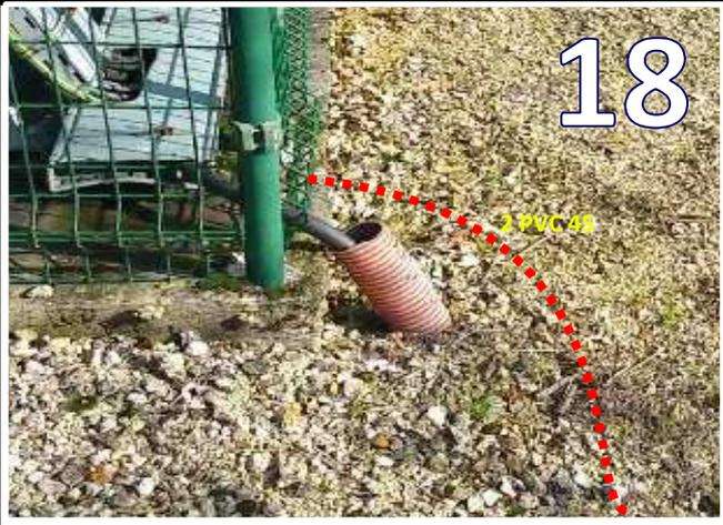
Pose de 2 PVC45 avec fil plynox en tranchée tradi en terrain naturel de largeur 40cm et profondeur 80cm
