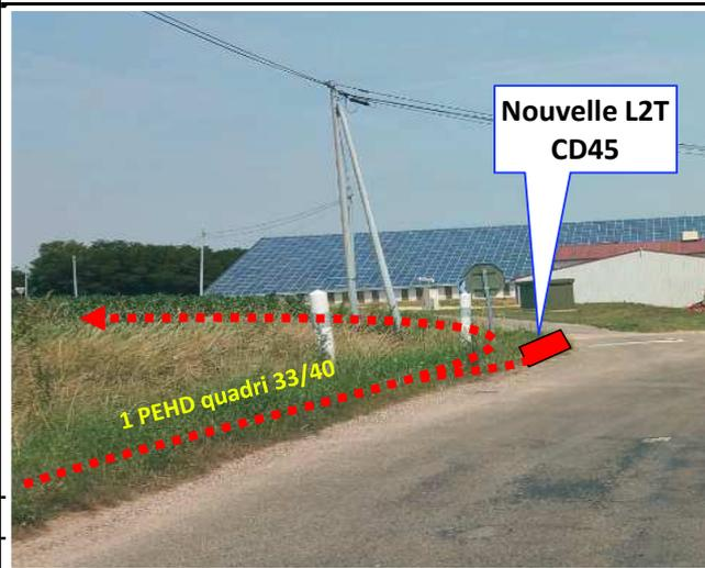
Pose d'une nouvelle L2T + Pose de 1 PEHD quadri 33/40 avec fil plynox en tranchée mécanisée (soc) en terrain naturel ou en accotement sur 60cm de profondeur
