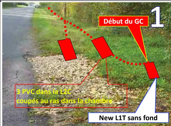
Pose L1T sans fond pour récupérer les fourreaux du poteau télécom et pose de 2 PVC 45 + 1 en attente en tranchée traditionnelle sur chaussée de largeur 40 cm et de profondeur 80cm
