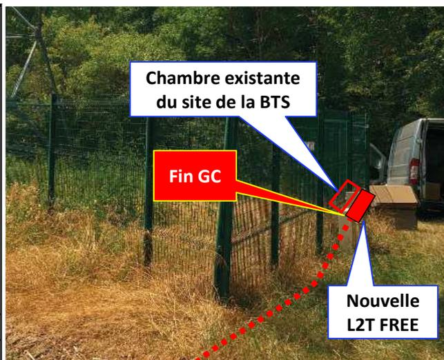
Pose de mini 2 PEHD 33/40 avec fil plynnox en tranchée mécanisée (soc) en terrain naturel ou en accotement sur 60cm de profondeur + 1 L2T FREE (percussion sur petit pied). Percutter les 2 x L2T sur les grands pieds et mettre 3 PVC de 45 en passage. Faire des masques propres
