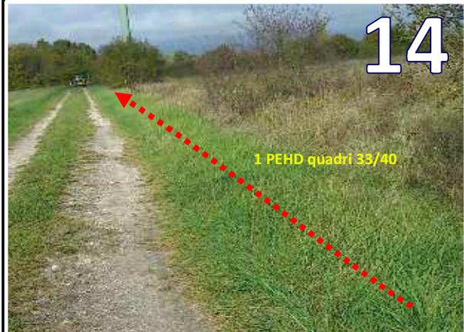
Pose d'un PEHD quadri 33/40 avec fil plynnox en tranchée mécanisée (soc) en terrain naturel ou en accotement sur 60cm de profondeur
