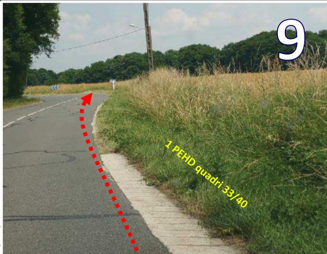
Pose de 1 PEHD quadri 33/40 non torsadé avec fil plynox en tranchée tradi sur chaussée de largeur 40cm et et profondeur 80cm.
