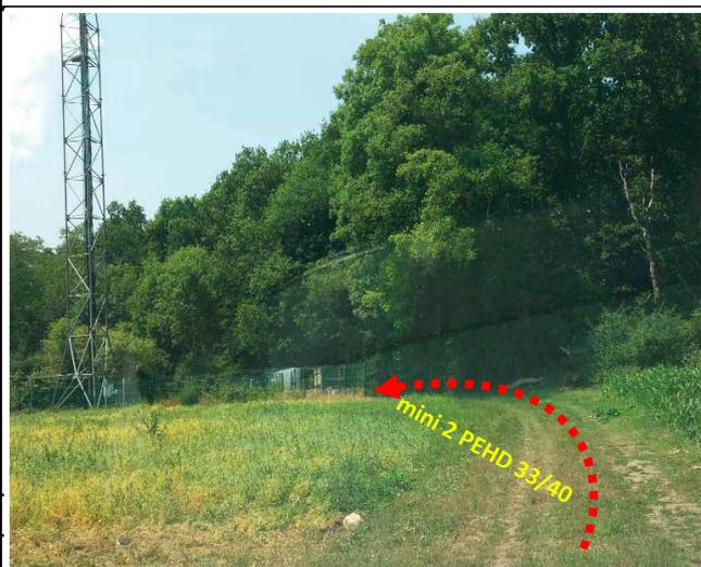
Pose de mini 2 PEHD 33/40 avec fil plynnox en tranchée mécanisée (soc) en terrain naturel ou en accotement sur 60cm de profondeur
