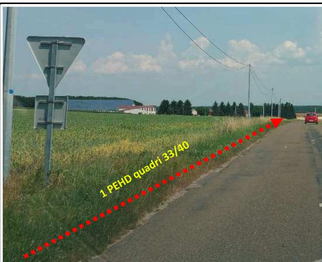
Pose de 1 PEHD quadri 33/40 avec fil plynox en tranchée mécanisée (soc) en terrain naturel ou en accotement sur 60cm de profondeur
