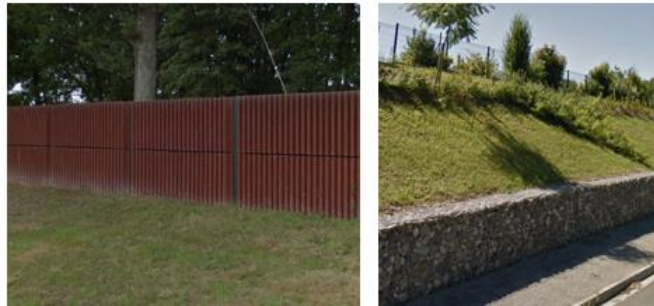
Écran antibruit et merlon aux abords du boulevard de l'Europe (RD834) à Lons
