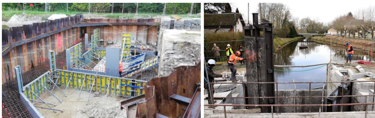
Ecluse de Vitry pendant la phase travaux
